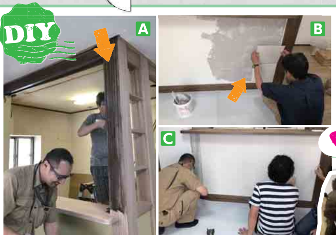
A 梁にリボスを使い塗装。社長とご主人で塗りました。 B C カットしたエコカラットをキッチンカウンターに。ご主人と息子さんと協力してエコカラットを貼りました。ワンちゃんのおいもエコカラットで解消!
