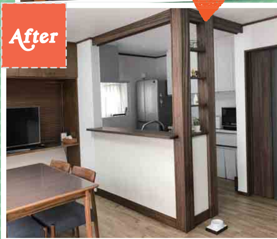
キッチン上を抜いて梁を付ける
