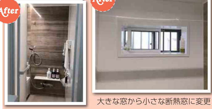
大きな窓から小さな断熱窓に変更
